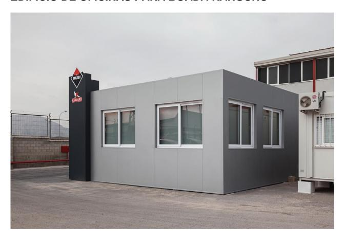
Desarrollo, fabricación y montaje de solución modular para edificio de oficinas centrales, anexo a las naves de producción. La altura libre interior supera los 2,5 metros e incluye elemento tipo "totem" en una de las equinas para dar mayor visibilidad a la construcción.
